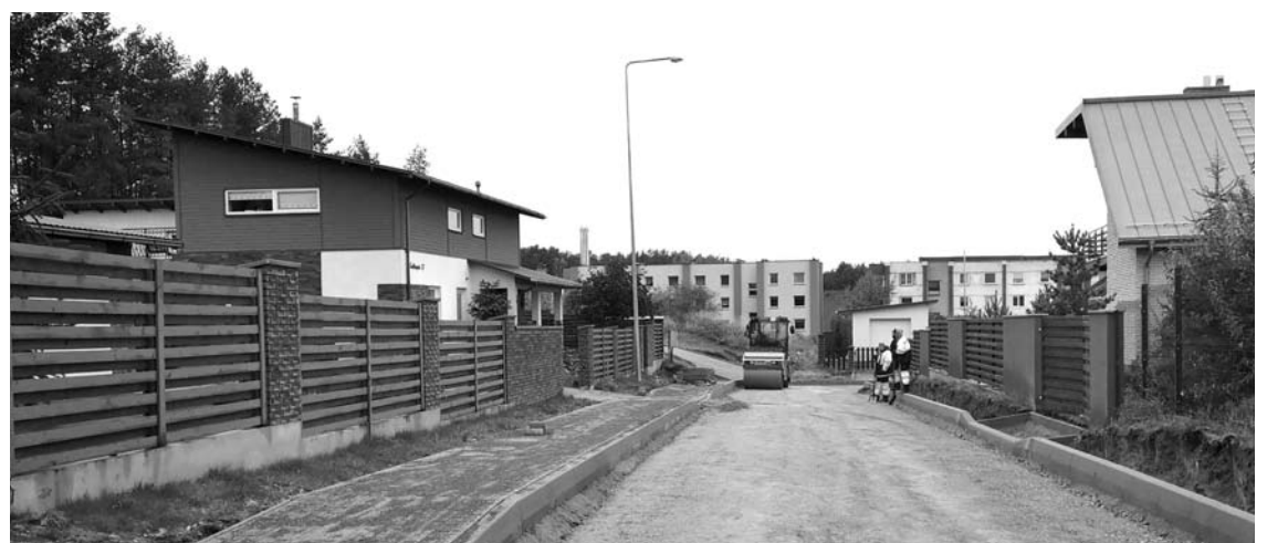
Asfaltuojamoje Šaltupio gatvės atkarpoje - vos keli gyvenamieji namai.
