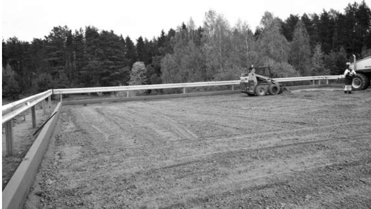
Šaltupio gatvės gale įrengiama pirmoji 400 kv. m. pločio apsisukimo aikštė šiukšliavežėms Anykščiuose.
